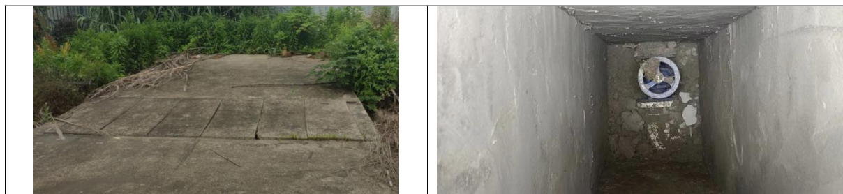
图3-5 事故应急池照片
